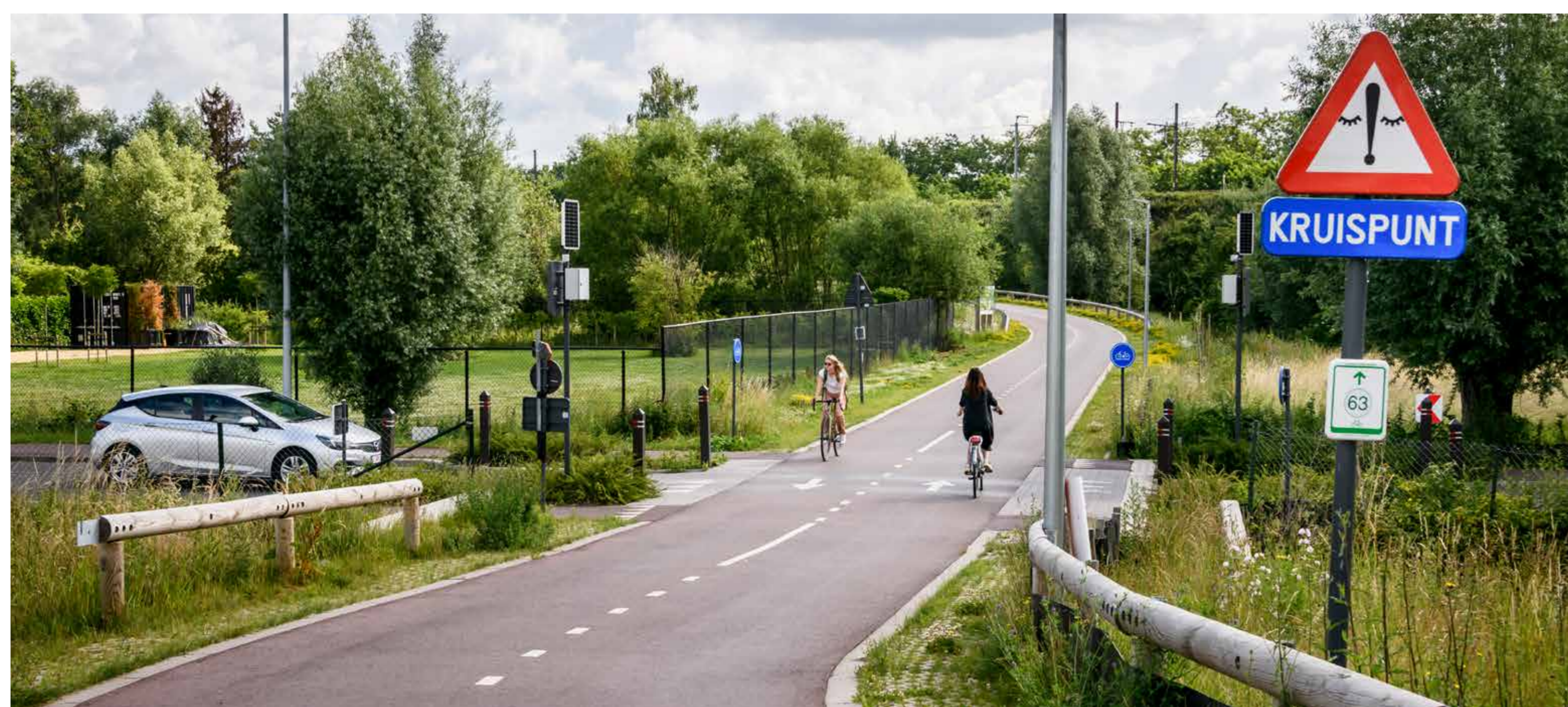
voorbeeld bordeauxrode asfaltlaag
