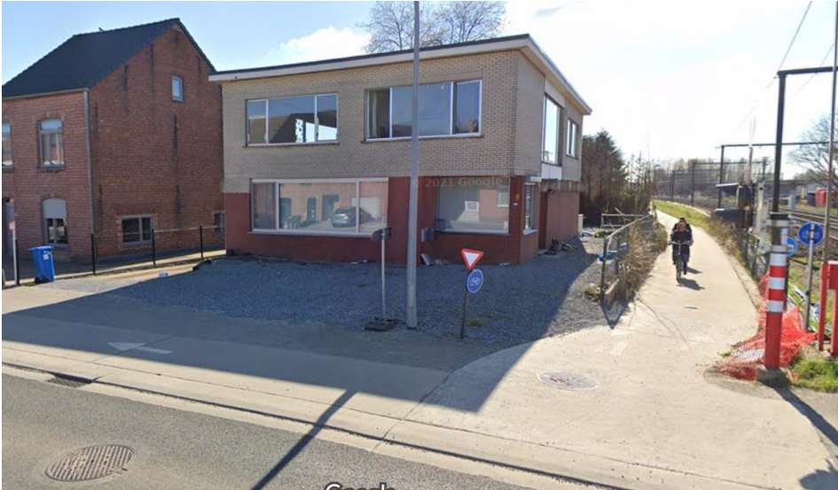
Figuur 3-17: Woning t.h.v. aansluiting Herseltsesteenweg x F106
